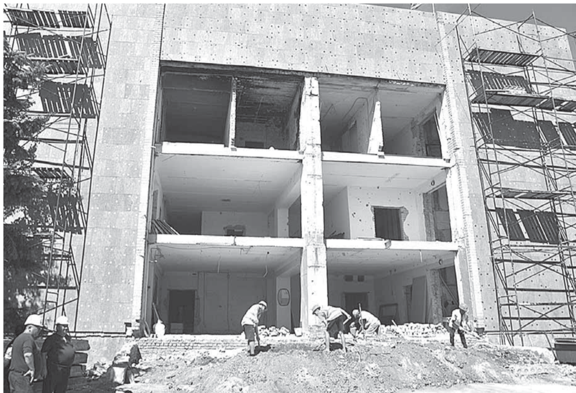
Восстановление станции переливания крови идет полным ходом
