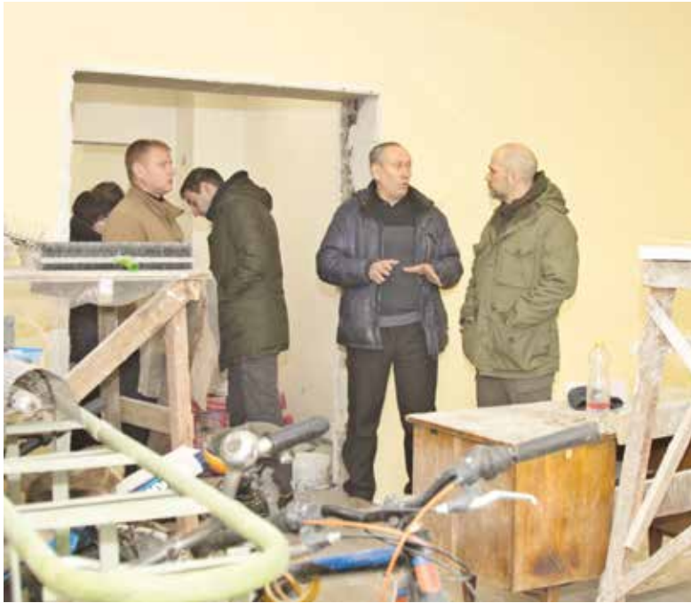
Проверка восстановительных работ
