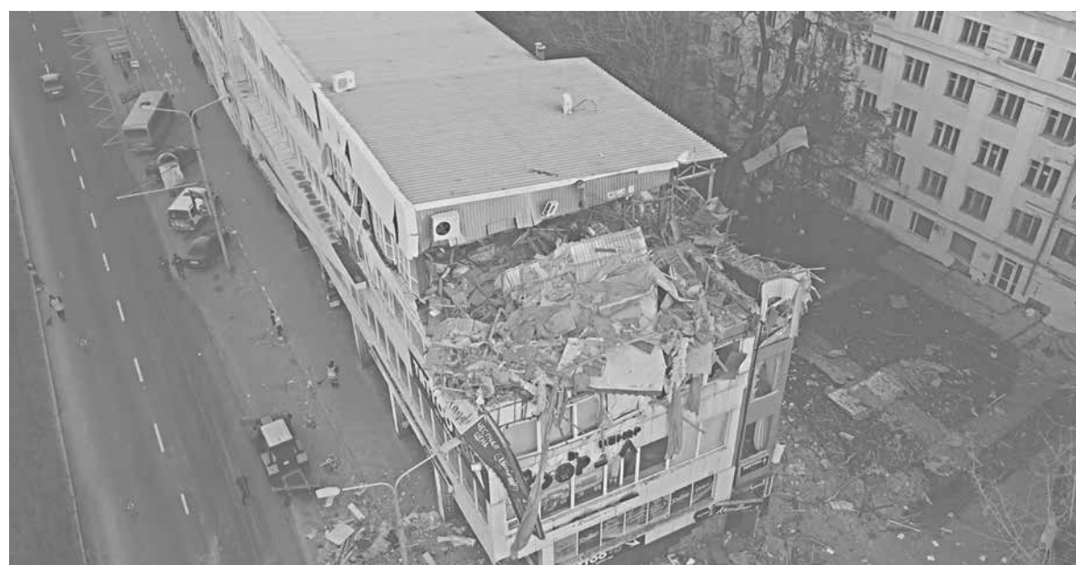
Последствия прилета на остановке транспорта «Студгородок»
