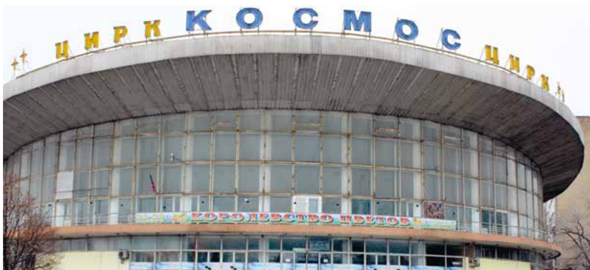
В донецком цирке «Космос» отремонтировали кровлю
