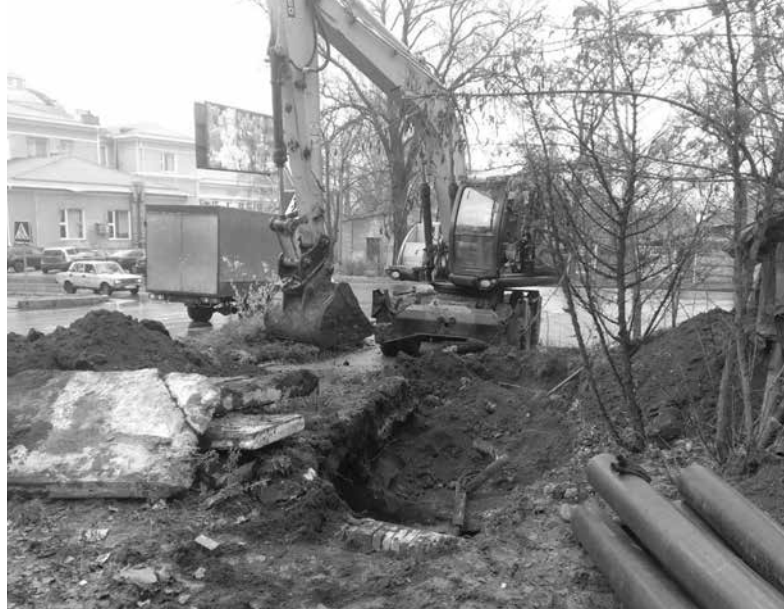
Замена труб на пересечении ул. Ткаченко и Куйбышева
