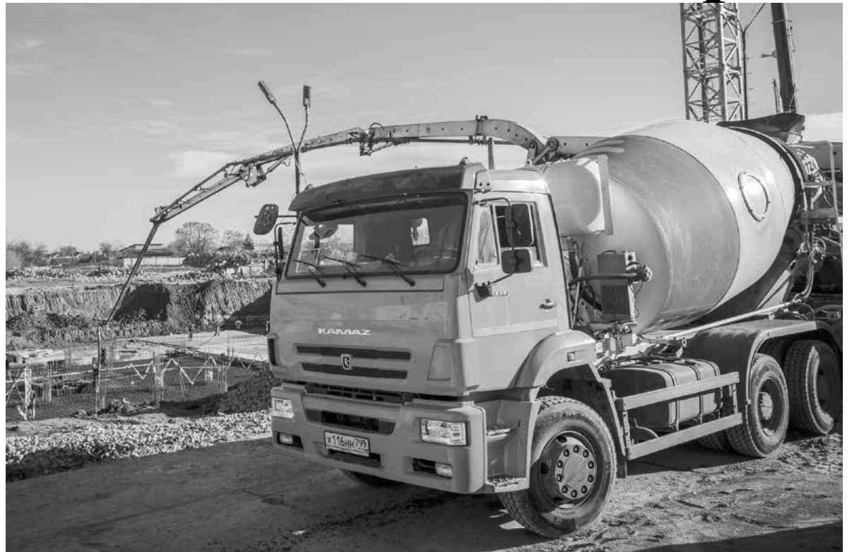
Стройка на объекте идет круглосуточно
