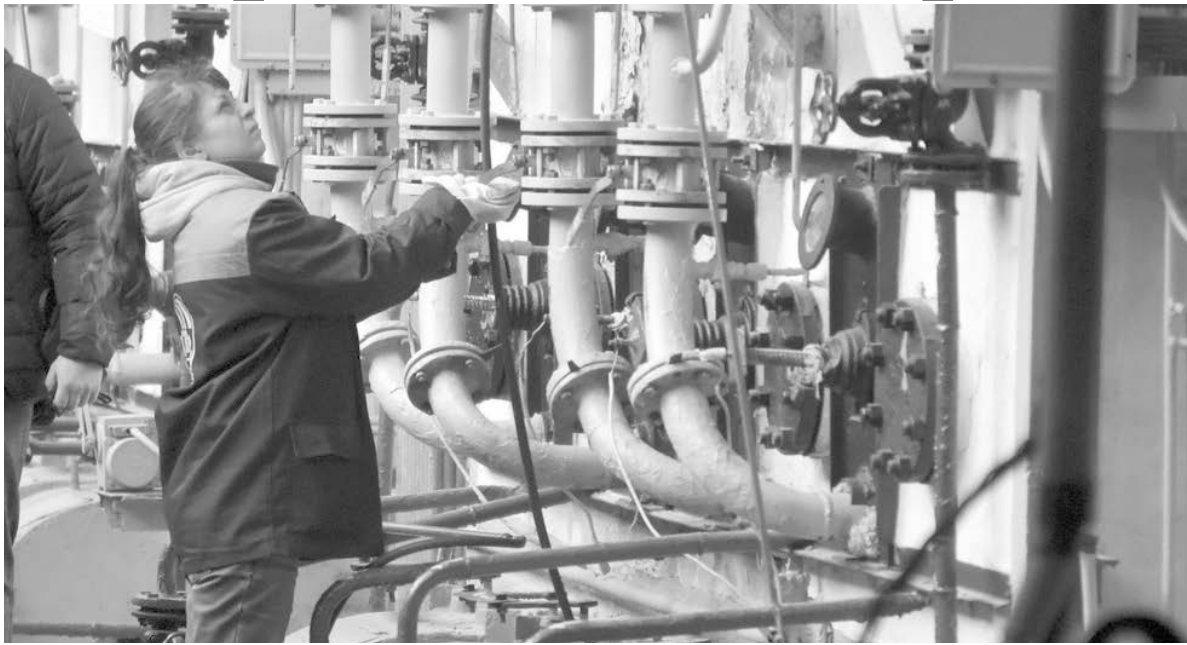
Котельная работает в штатном режиме
