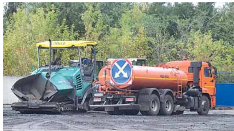
Подготовительные работы практически завершены
