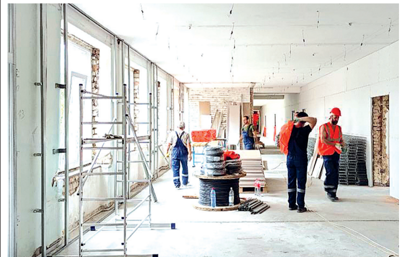
Строители из Подмосковья работают в две смены
