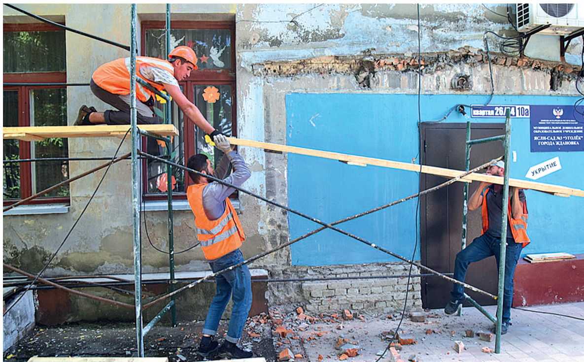
Магаданские строители за работой
